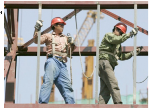
Los empleos en construcción tienden a ser precarios.
